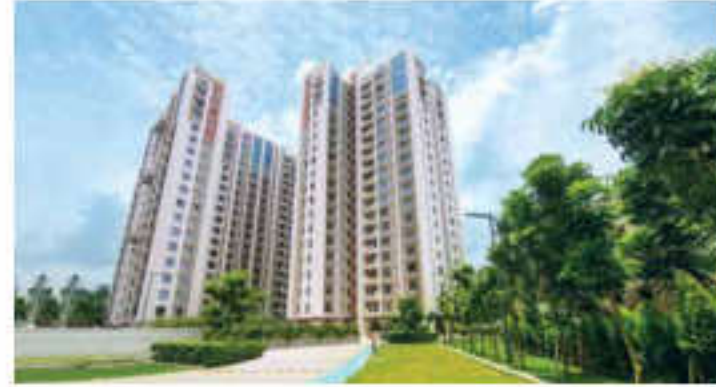
OZONE On South EM Bypass
